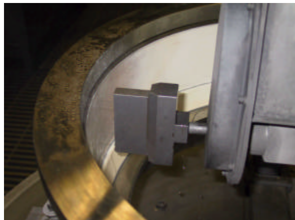
BILD 17: Entschichtung durch Hochdruckwasserstrahlen.
