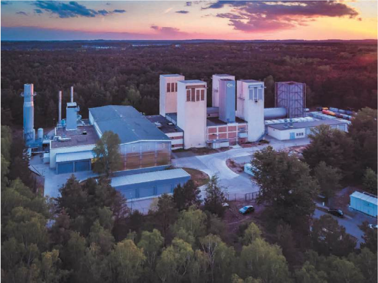
Abbildung 5: Prüfstandsgelände der MTU Maintenance Berlin-Brandenburg GmbH
