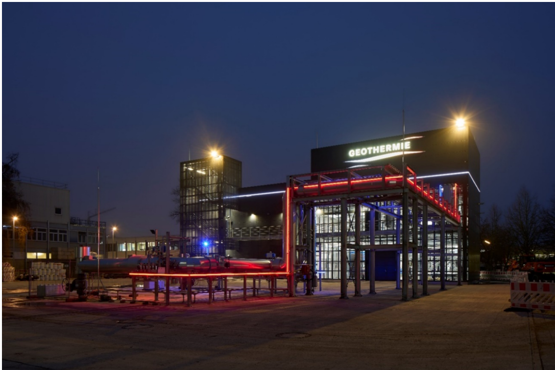
Abbildung 5: Tiefengeothermieanlage am Standort München
